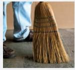
1. **Limpieza;** el firme donde se instalará la baldosa deberá estar nivelado totalmente limpio y libre de humedad.
