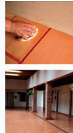
6. **Acabado final;** una vez instalada la baldosa aplique nuevamente el sellador de su elección. Es de suma importancia no saturar el piso con agua durante la limpieza o dañara el sellador aplicado. Asegúrese de resanar y sellar perfectamente las boquillas para evitar filtraciones de humedad.
