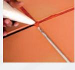
5. **Emboquillado;** aplique una boquilla mínima de 15 mm (5/8"). Utilice una llana de hule o dulla para remeter la boquilla, no manche o esparza la mezcla sobre la baldosa, sea especialmente cuidadoso en no rayar el pre-sello de la baldosa con la llana y la arena del emboquillador.
