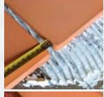
4. **Instalación;** utilice solamente adhesivo blanco para pisos en la instalación de la baldosa. No use cemento gris pues este manchará la baldosa.
